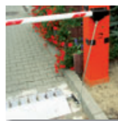
Mechaniczne połączenie kolczatki ze szlabanem.
